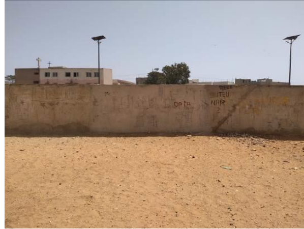
Photo 75 - Mur refait servant initialement d'accès pour les travaux sur l'autoroute à péage (SOFRECO/EGIS, 2022)
