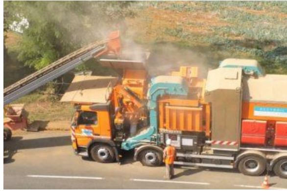
Photo 90 - Recyclage in situ de déblais de chantier (Source : la gazette des communes)
