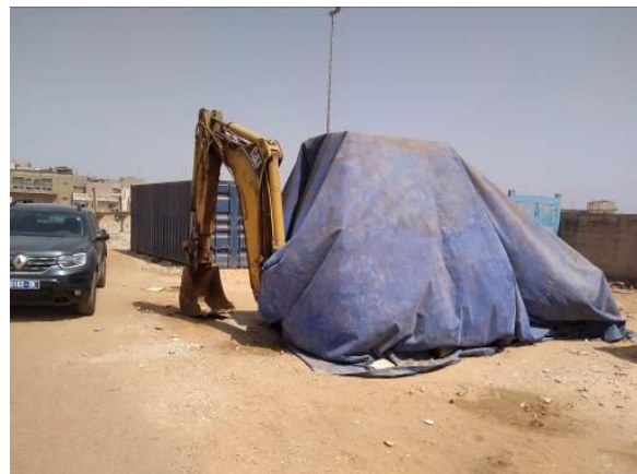
Photo 79 - Installations actuelles en cours de repli (SOFRECO/EGIS, 2022)
