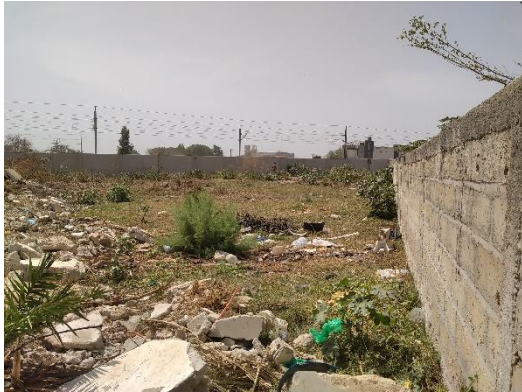
Photo 68 - Site de cité Millionnaire (SOFRECO/EGIS, 2022)
