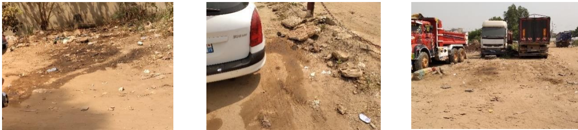
Figure 145 - Traces de polluants sur l'axe Kounoune – Cap des Biches (Sofreco / EGIS)
