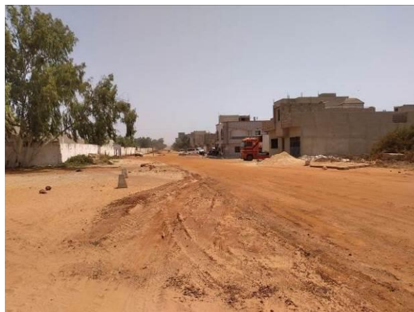
Photo 71 - Route latéritique réalisée par Elecnor (SOFRECO/EGIS, 2022)
