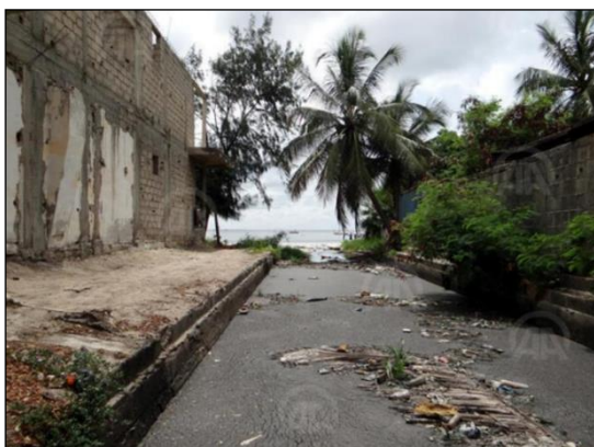
Photo 27 – Rejets dans la baie de Hann des eaux usées (AA, 2021)
