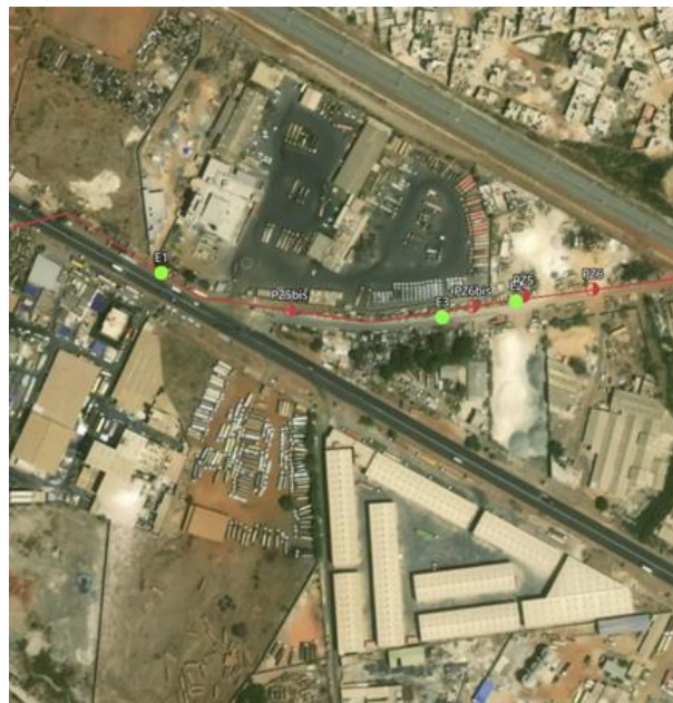
Figure 25 - Piézomètres installés sur le tracé du lien Kounoune-Cap-des-Biches (1/2) (Fondasol, 2021)
