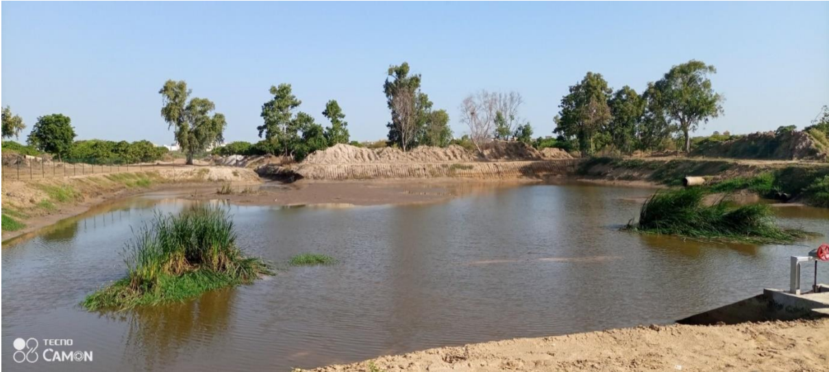
Photo 93 - Vue d'un des bassins de rétention creusé par l'ADM dans la forêt classée de Mbao. Au fond à gauche est la sortie du bassin. À droite, il s'agit de la conduite vers le Mare de la Biodiversité. Le niveau d'eau n'est pas suffisamment élevé pour que l'eau du bassin s'écoule à travers la conduite vers la Mare.
