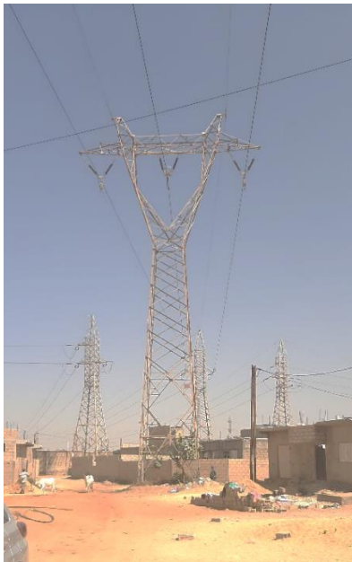
Photo 25 - Empiètement de maisons sur le tracé des pylônes électriques (photo Cabinet Haussmann)
