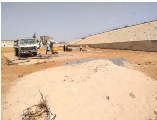
Photo 80 - Vue du site actuel de Guinaw Rails avec équipements (SOFRECO/EGIS, 2022)
