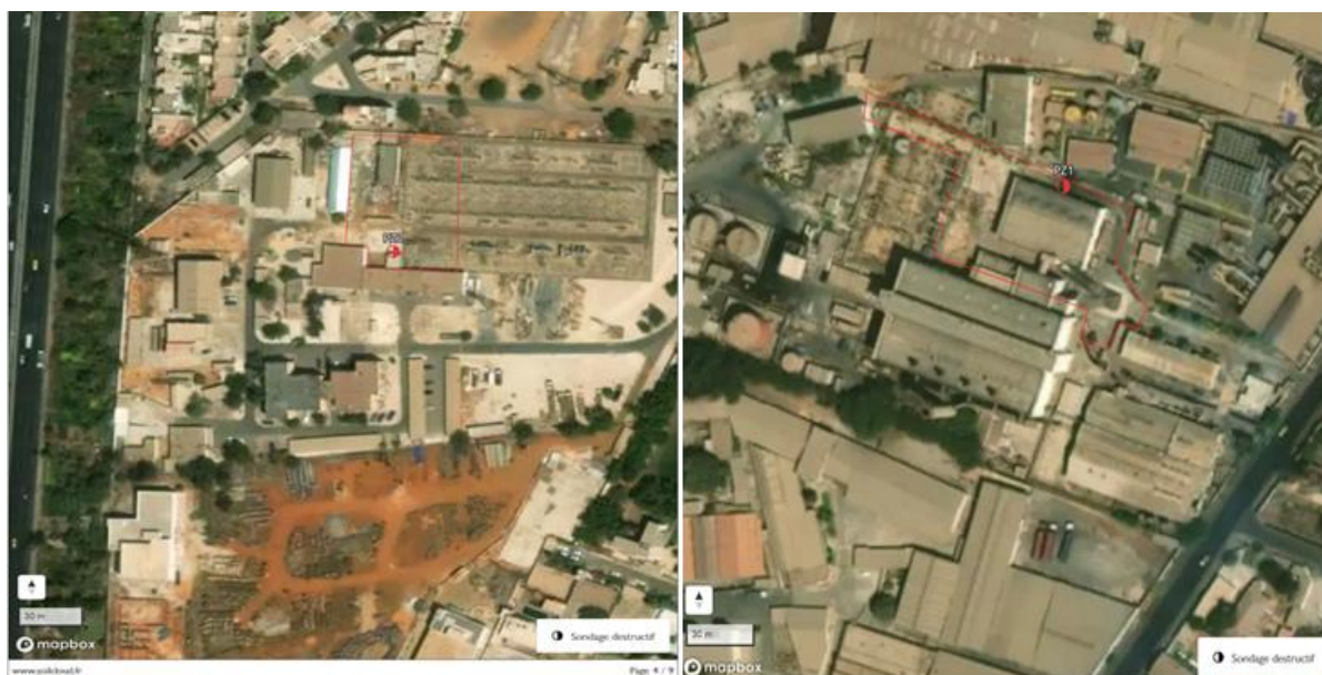
Carte 27 - Piézomètre PZ2 du poste de Hann / Piézomètre PZ1 du poste de Bel-Air (Fondasol, 2021)
