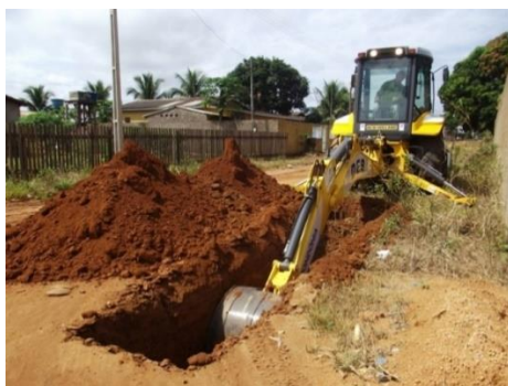
Figure 150 - exemple de dispositions des déblais au niveau des tranchées (Source : rondoniagora.com)
