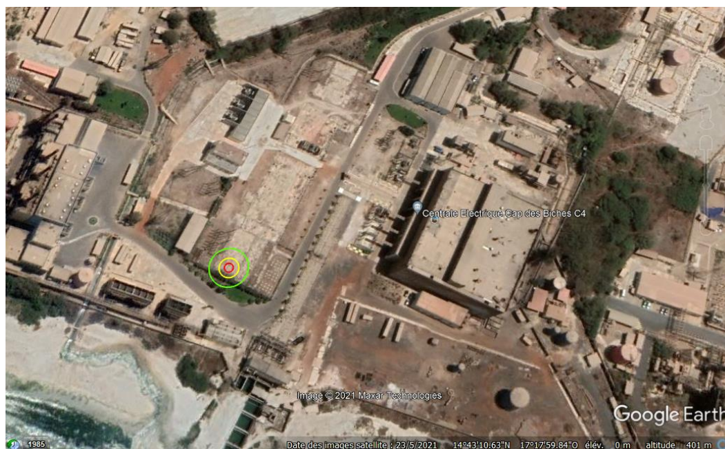
Figure 137 - Représentation graphique de l'explosion d'un nouveau transformateur dans Cap des Biches
