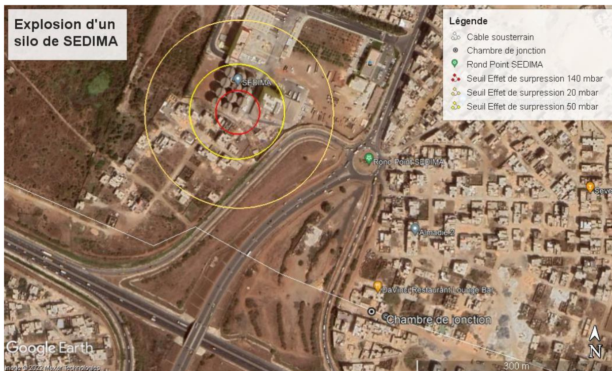
Figure 126 - Représentation de l'explosion de silo de la SEDIMAP
