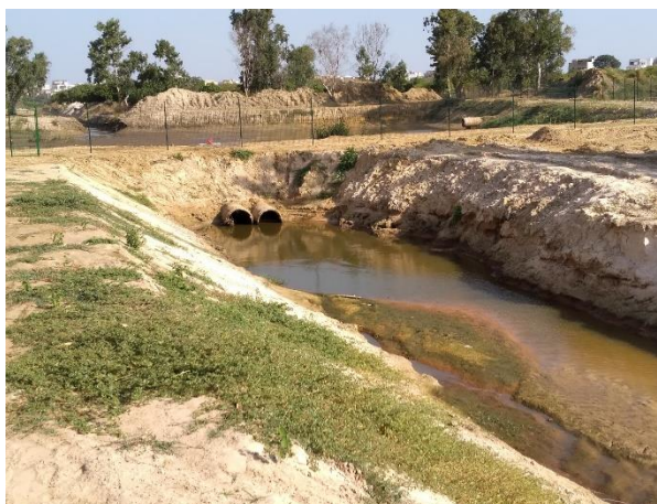
Photo 7 – Bassins de rétention des eaux pluviales aménagés par l'ADM en 2021 (P. Ndiaye, 2021)
