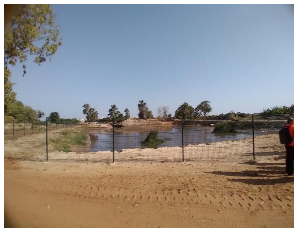
Photo 8 - Bassins de rétention des eaux pluviales aménagés par l'ADM en 2021 (P. Ndiaye, 2021)
