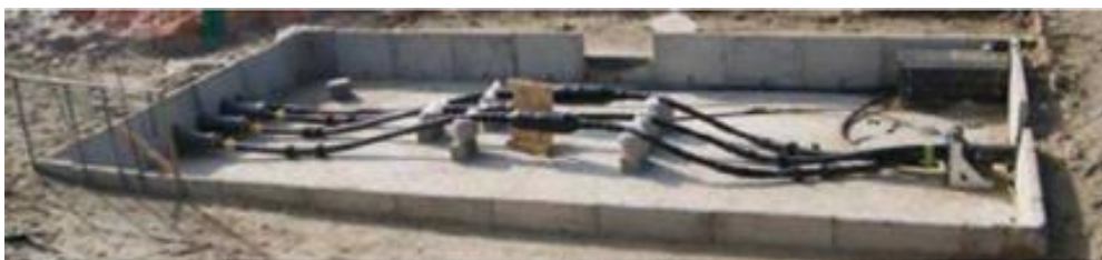
Photo 4 – Exemple de chambre de jonction d'atterrage en travaux (Nexans, 2016)
