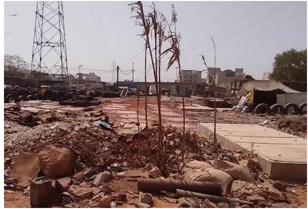
Photo 84 - Activités de tannage sur la voie d'entrée initiale et chambres de jonction actuelles (SOFRECO/EGIS, 2022)
