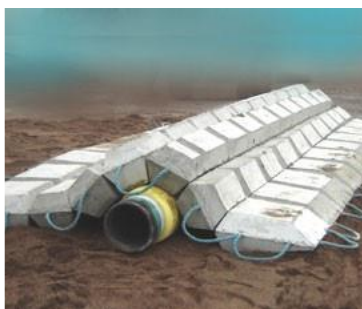
Figure 100 - Matelas en béton
