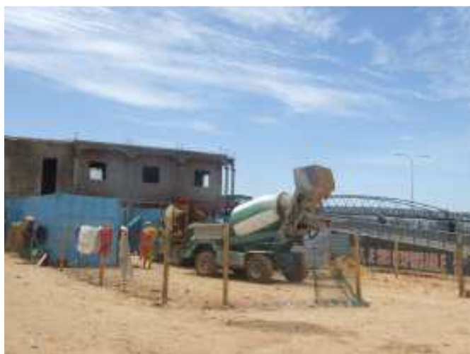
Photo 62 - Bureau base chantier entre PK 14+660 et 14+680 occupée par l'entreprise chargée des travaux de Senelec de la ligne souterraine Poste Patte d'oie – Kounoune (source EIES du cabinet EES)
