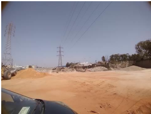
Photo 85 - Lignes HT sur la base vie (SOFRECO/EGIS, 2022)
