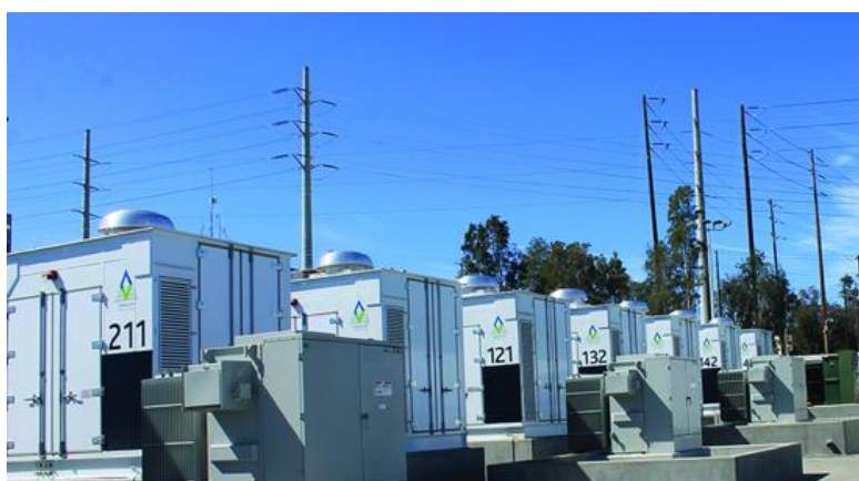
Parc de Batteries de Stockage d'Énergie
